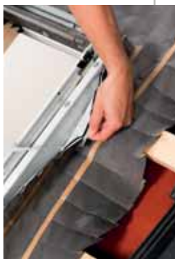
Alátétfólia vízelvezető csatornával
