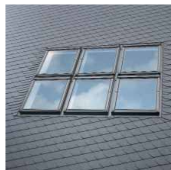
EKS keret Max. 8 mm profilmagasságú (pl. pala, bitumenzindely) vagy dupla (2x8 mm) fedéshez
